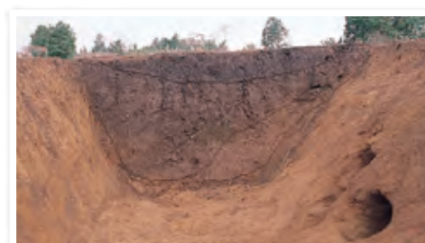
内壕…断面が逆台形です。
